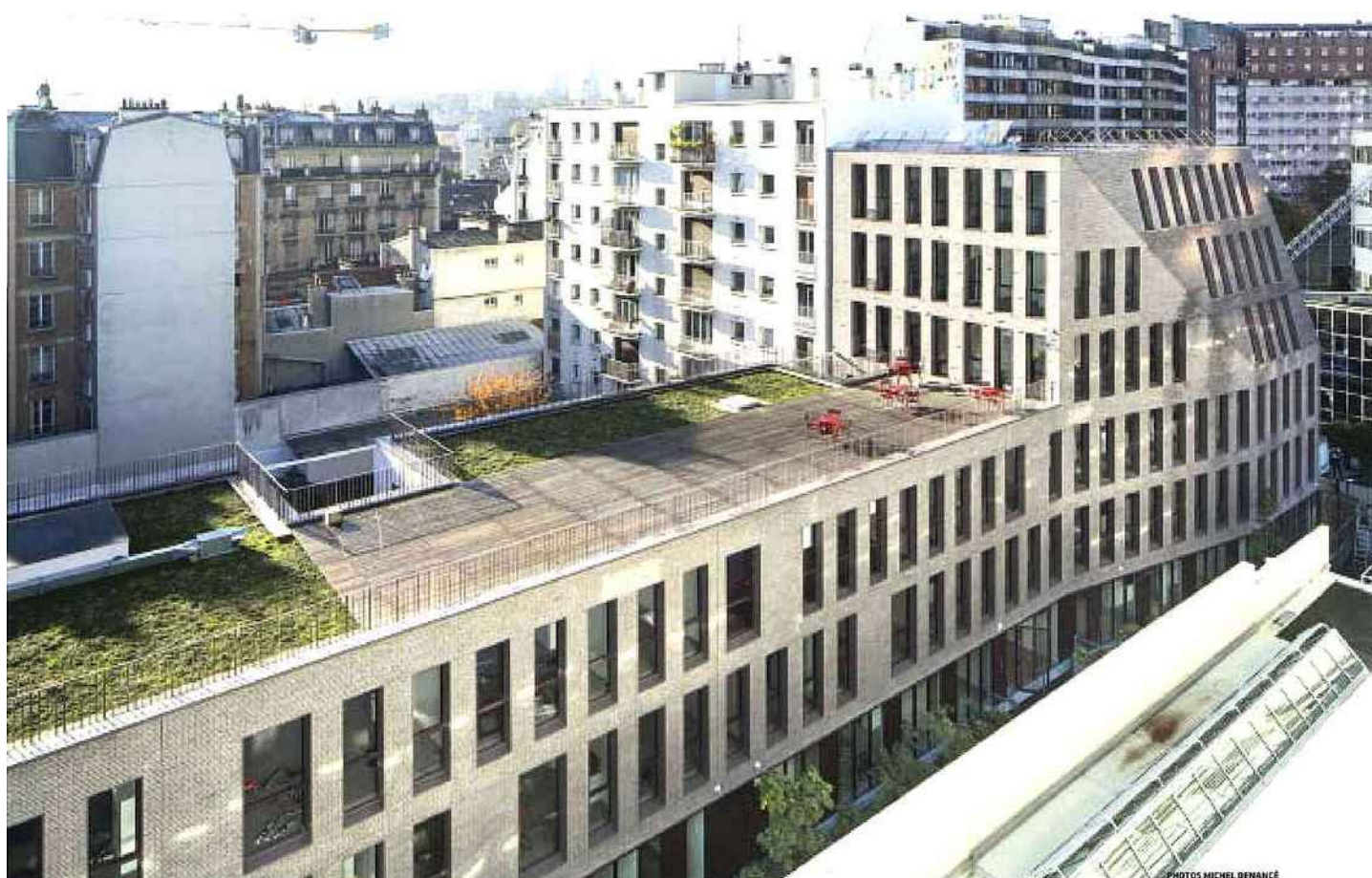
En cœur d'îlot, les façades sont largement vitrées. Une pergola métallique relie les corps de bâtiment dans le sens transversal et une autre, en béton, dans le sens longitudinal. Côté rue, les façades (photo ci-dessous) sont revêtues de briques en référence à l'histoire industrielle de Pantin. Par leur homogénéité, elles contribuent à la recomposition du secteur.
